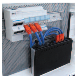
Zabudowa komponentów multimedialnych dzięki perforowanej płycie montażowej.
